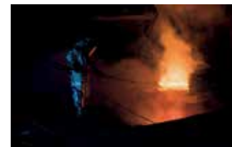
82-83 Companhia Siderúrgica do Atlântico, alto-forno – Rio de Janeiro (RJ). Companhia Siderúrgica do Atlântico, blast furnace – Rio de Janeiro, RJ
