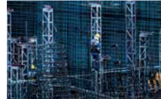
100-101 Detalhe pequena hidrelétrica em construção no Rio Paraíba do Sul – Queluz (RJ). Small hydroelectric plant under construction on the Rio Paraíba do Sul (detail) – Queluz, RJ
