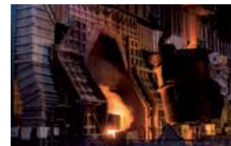
74-75 Companhia Siderúrgica do Atlântico, alto-forno – Rio de Janeiro (RJ). Companhia Siderúrgica do Atlântico, blast furnace – Rio de Janeiro, RJ
