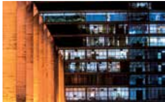
94-95 Detalhe do Itamaraty com prédio do ministério da Saúde ao fundo – Brasília (DF). Itamaraty Palace (detail) with Health Ministry building in the background – Brasília, DF
