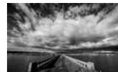
Página 142 Ponte da velha cidade de Canudos inundada em 1969 que reapareceu com a baixa das águas do açude Cocorobó – Canudos (BA). Bridge in the old city of Canudos, flooded in 1969, which reappeared when water levels dropped in the Cocorobó reservoir – Canudos (BA).
